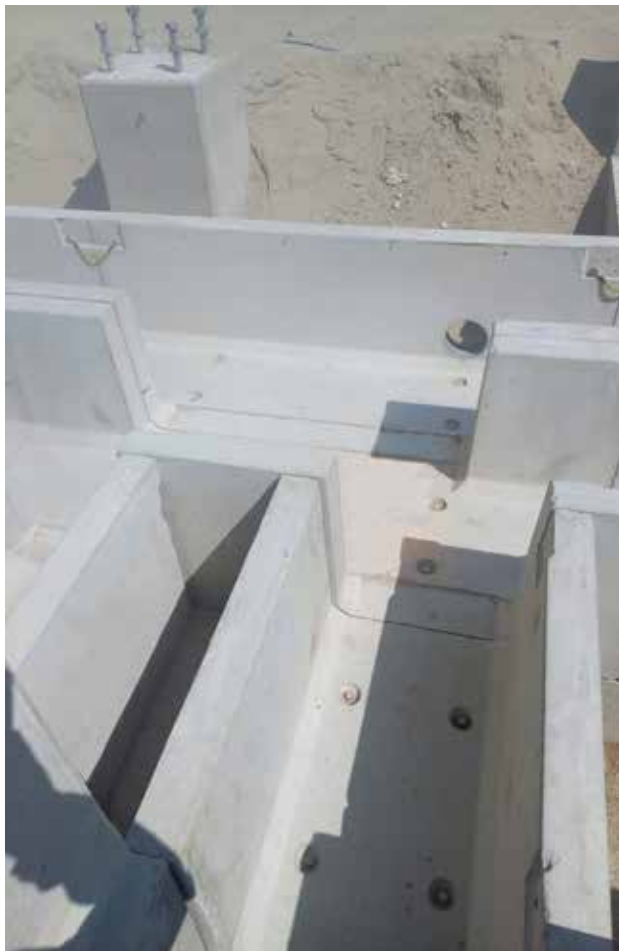
Voorbeeld van een T aansluiting
