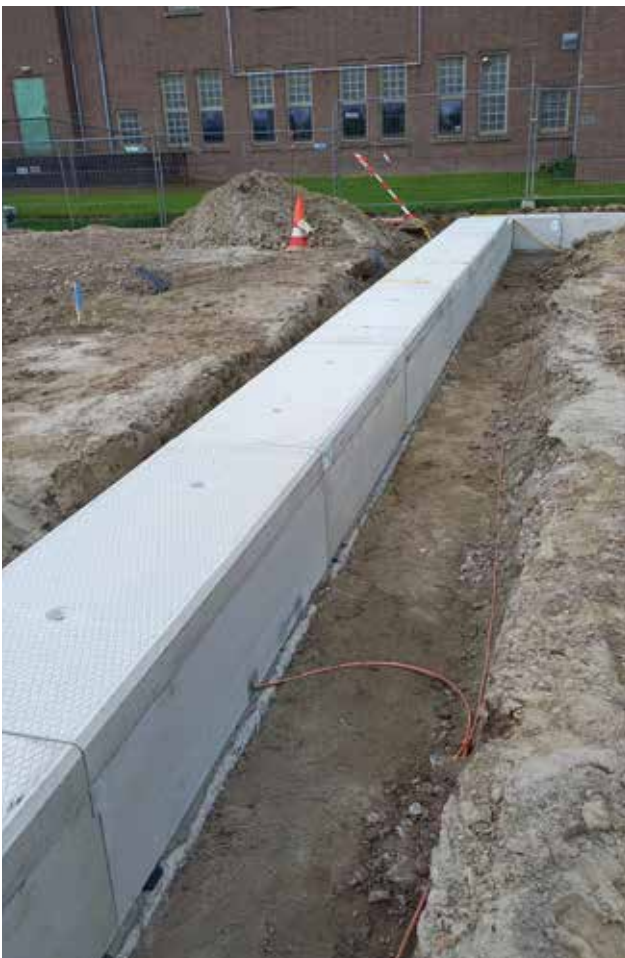
Voorbeeld aansluiting aardingskabel
