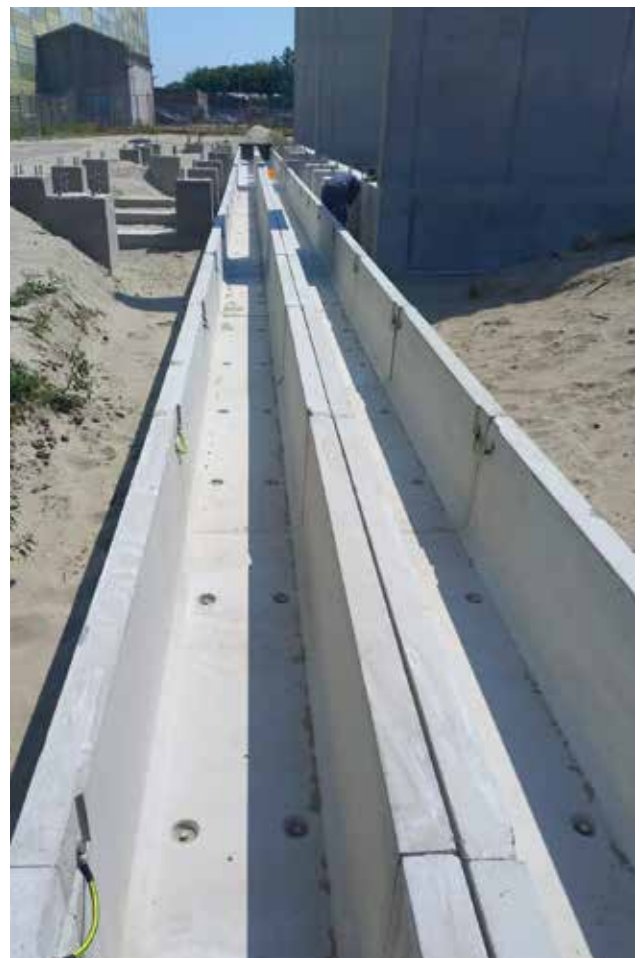
Voorbeeld dubbele gootconstructie
