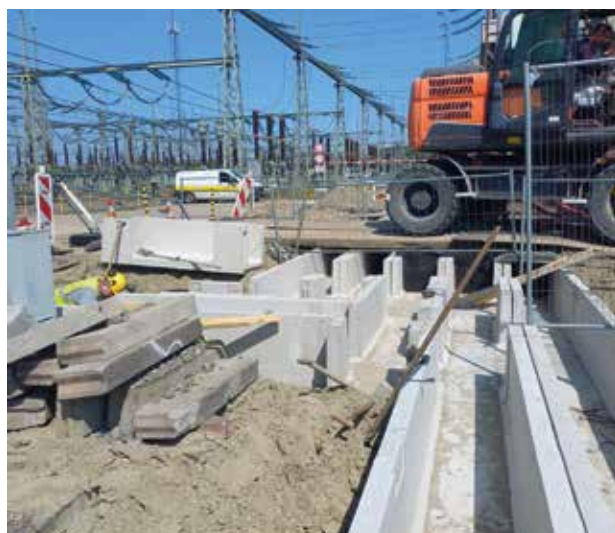
De SOLID kabelgoot is zo sterk dat hij al in de bouwfase (mits afgedekt) belast kan worden.
