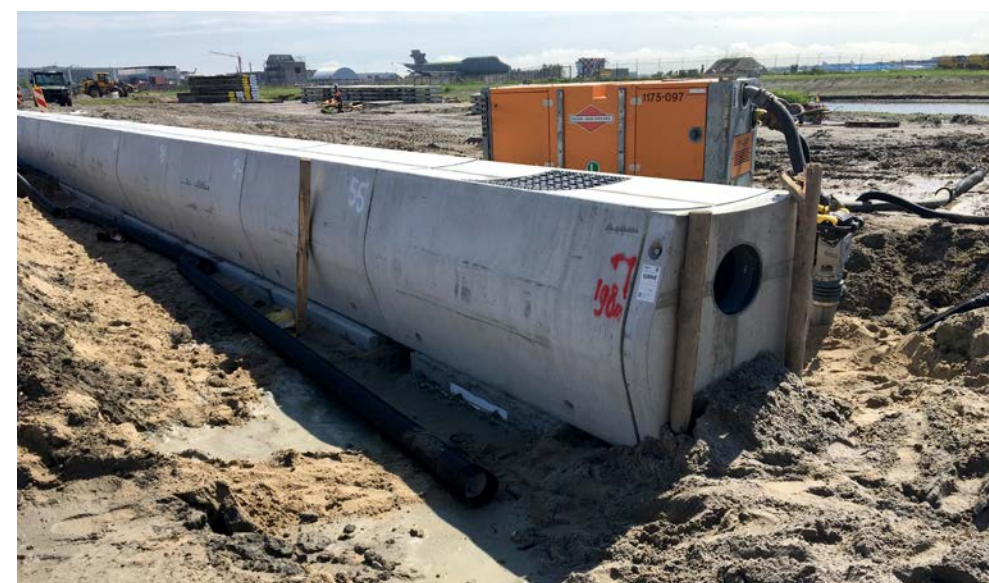
TBS-SVA ontwikkelde splinternieuwe rooster buffergoten in een grotere afmeting die geschikt zijn op plekken waar water vaak snel moet afstromen.
