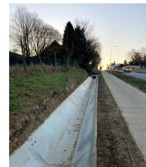
Voor het bufferen en vertraagd afvoeren of infiltreren langs wegen of (industrie)terreinen, biedt TBS-SVA de AQUAWAY® betonnen grachtelementen.
