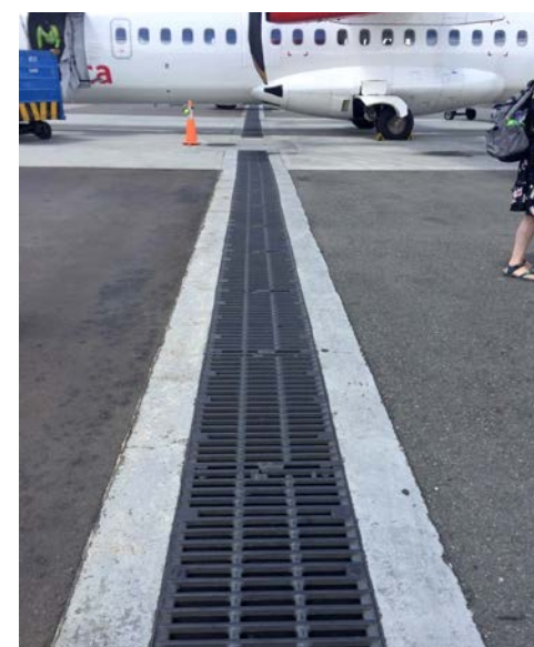
TBS-SVA ontwikkelde splinternieuwe rooster buffergoten in een grotere afmeting die geschikt zijn op plekken waar water vaak snel moet afstromen.
